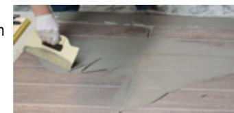
3. Nettoyer le support avec une éponge humide au fur et à mesure de l'avancement. Utiliser l'éponge humide et propre permet de lisser le joint.
