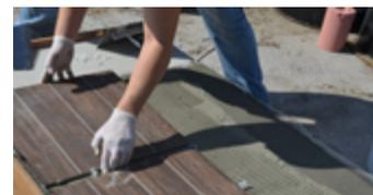
6. Appuyer sur le carreaux l'aide d'un outil en caoutchouc jusqu'à ce que la surface soit nivelée.
