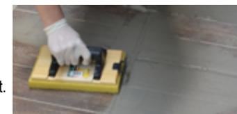
4. Après le séchage complet, passer un chiffon sec sur la surface pour éliminer le voile de ciment.
