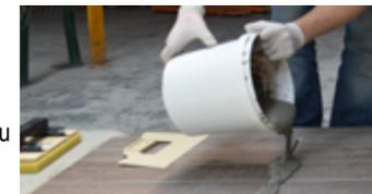
2. Étaler le mortier avec une raclette en diagonale, pour bien remplir les joints. Enlever l'excédent en passant l'outil, toujours en diagonale, pour ne pas creuser les joints.
